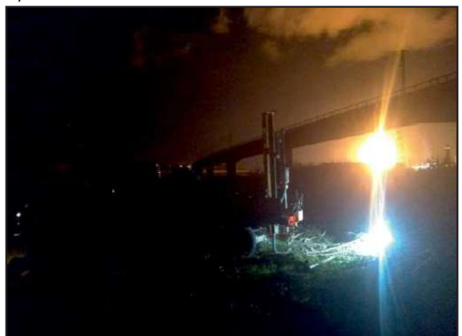
Emplaçament del penetròmetre P-1.
