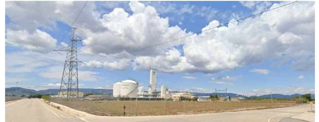
Vista de les parcel·les des del vial sud existent. Al fons Carburos Metàlicos i a la dreta Messer Ibérica
