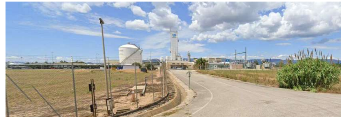
Vista del vial que separa les dues parcel·les: a la dreta, la zona verda, i a l'esquerra, envoltada per una tanca, la zona d'equipaments.
